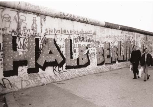
Foto/Photo: Holger Kulick
